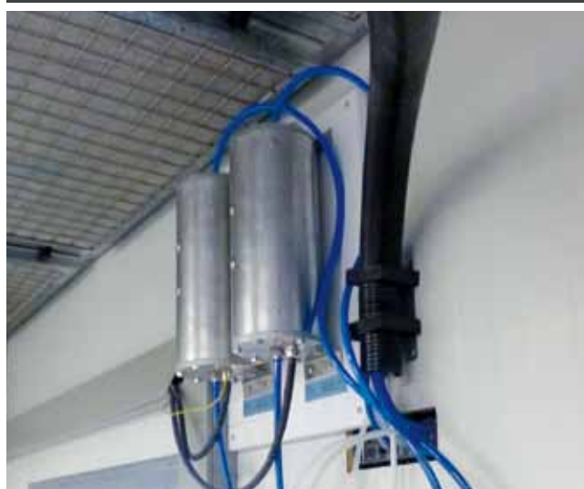
az airmatic ATEX jóváhagyással rendelkező ionizáló egysége a lehető legközelebb helyezhető el a festékszóráshoz
