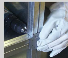
beépítő keret összeépítése
